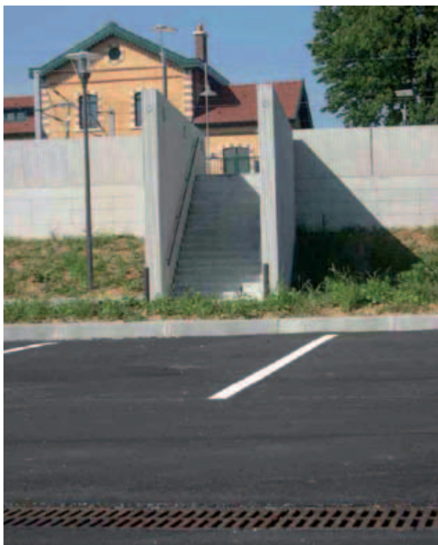
Noisy Le Roi, Francie: parkoviště u železniční stanice
