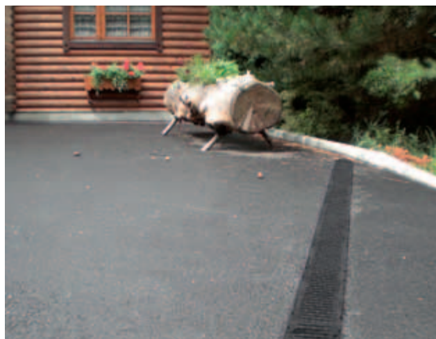
Vjezdy do dvorů a garáží
