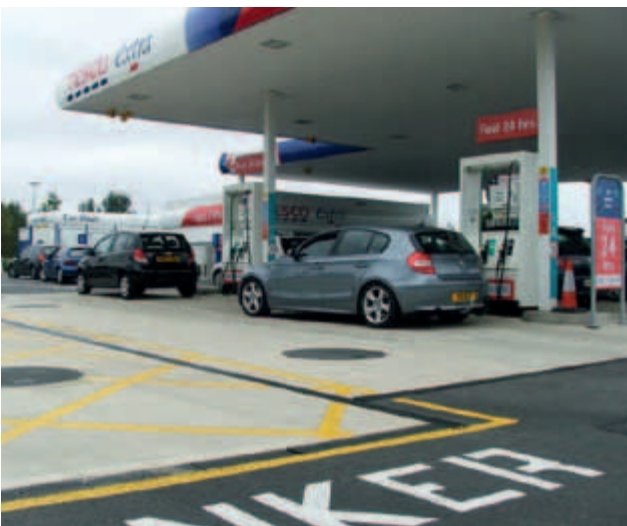
Čerpací stanice po celém světě
