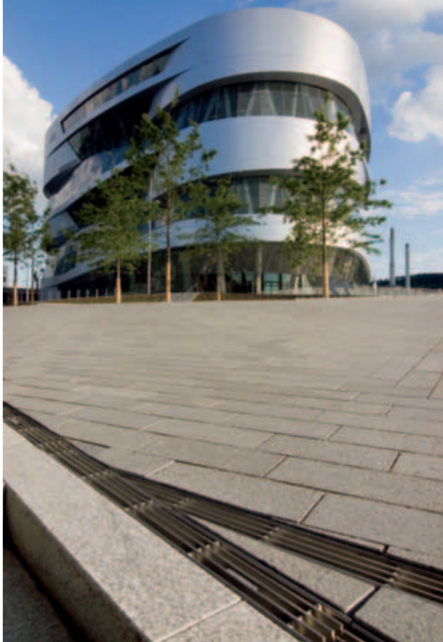
Nerezové odvodňovací žlaby byly navrženy v souladu se specifickými požadavky stavby.
