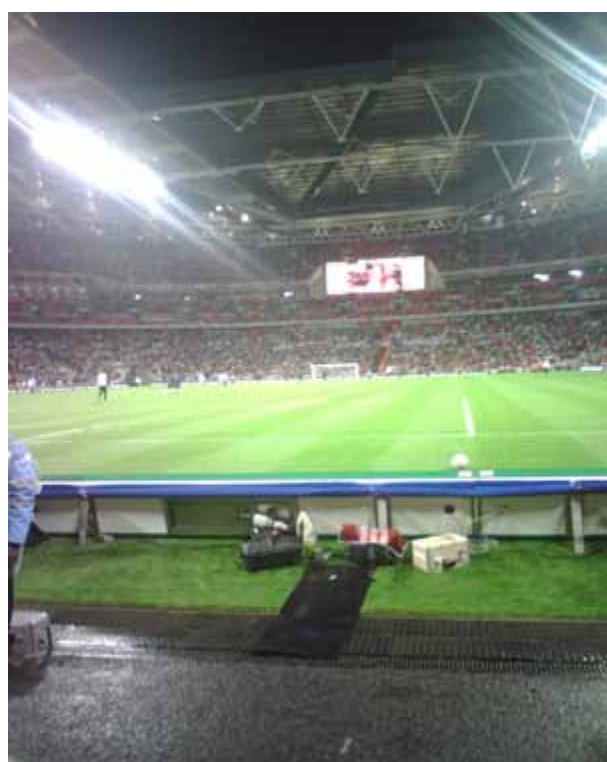
HAURATON kabelové žlaby na stadionu Wembley ve Velké Británii
