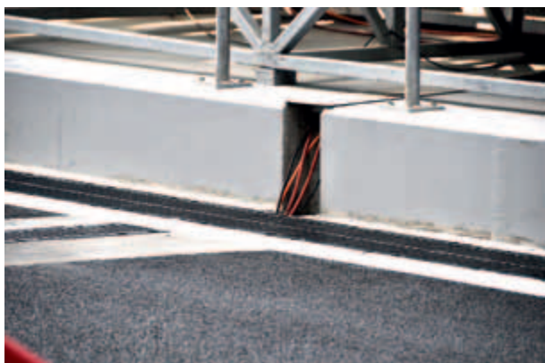
Na okruhu Yas Marina v Abu Dhabi jsou použity kabelové žlaby v boxech
